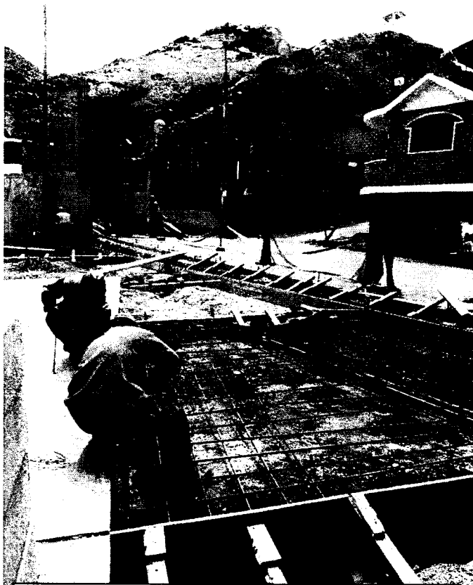
HABILITACIÓN DE ACERO Y ENCOFRADO EN LOS PAÑOS DEL PATIO DE MANIOBRAS
